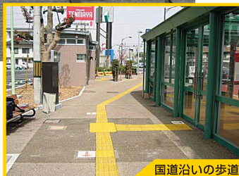
国道沿いの歩道
